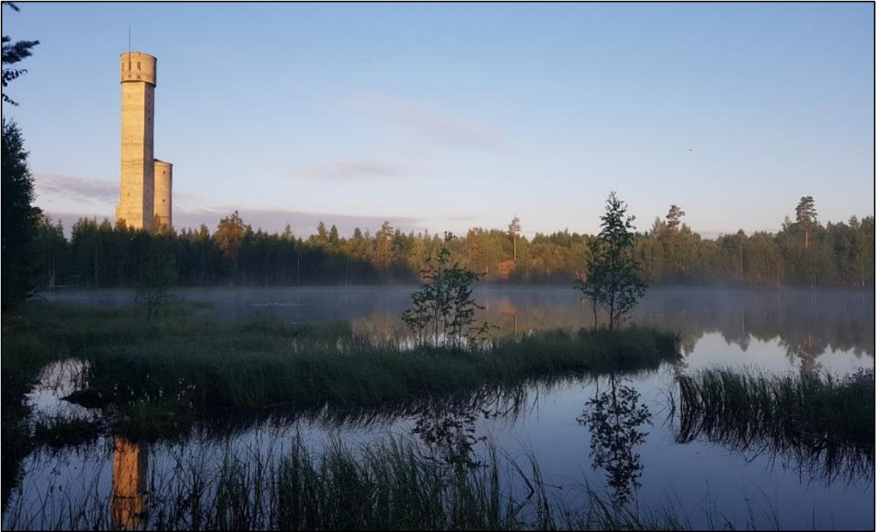
Kuva 108. Keretin torni Suu-Särjeltä etelään katsottuna. Keretin 96-metrinen torni näkyy kaivosalueelta kauas Suu-Särjelle asti muun rakennuskannan jäädessä puuston taa näkymättömiin.
