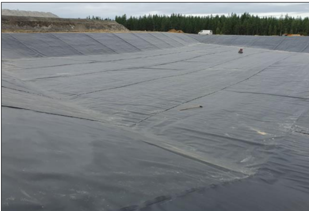
Kuva 21. Esimerkki rakenteilla olevasta vesialtaasta. (Kuva: Envineer Oy)
