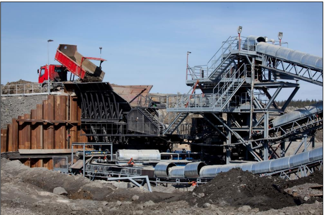
Kuva 14. Esimerkki malmin murskauslaitoksesta Pampalon rikastamolla. Pampalon murskaamo on toteutettu ilman suojarakennuksia. Hautalammen murskaamojen ympärille tulee rakennukset ja pölynpoisto. (Pampalon rikastamo, Endominex Oy)
