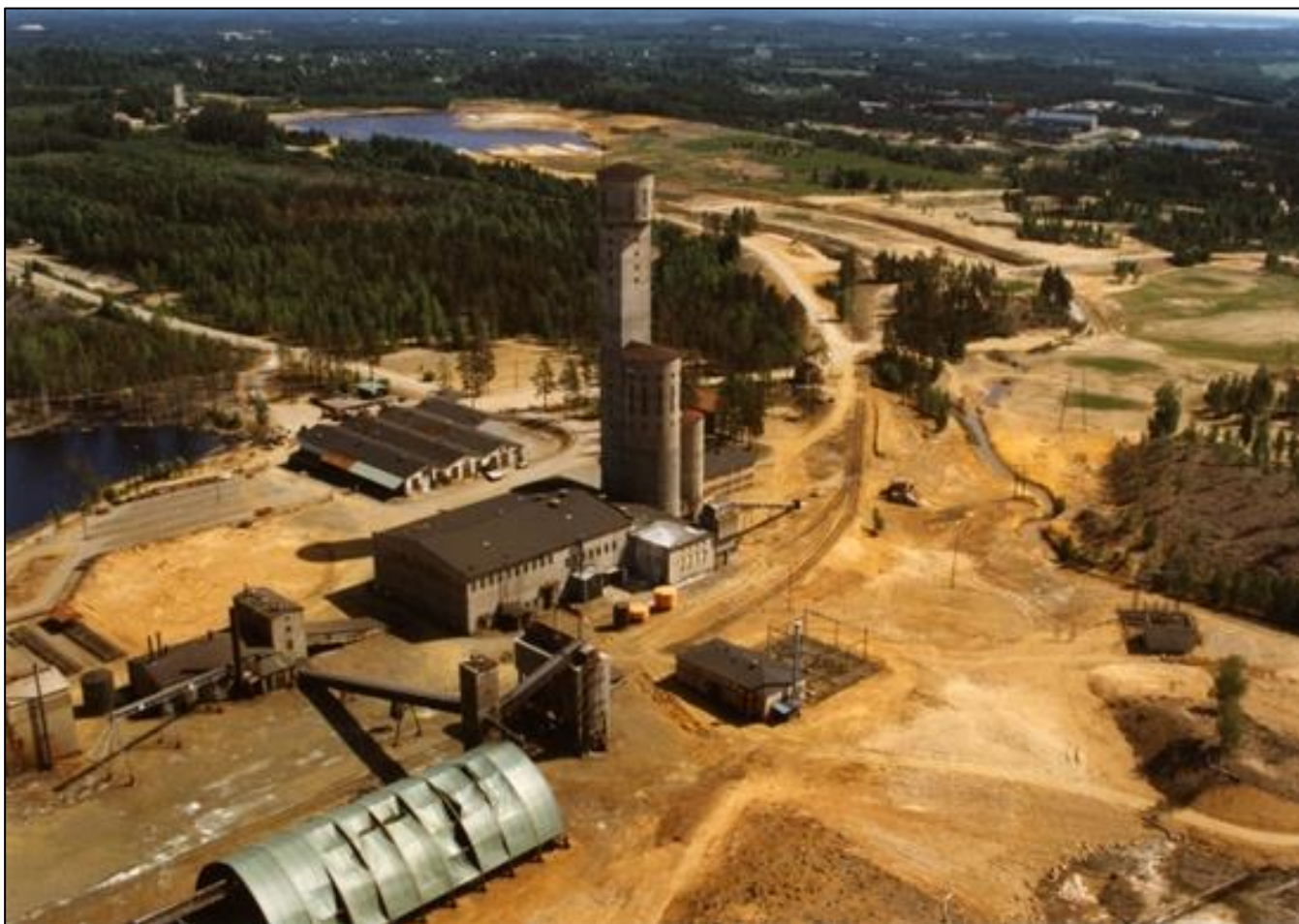
Kuva 115. Keretin kaivostorni sekä alueelta purettuja rakennuksia vuonna 1990. (Museovirasto, 2022) Nykyisin alueella on jäljellä enää kaivostorni ja siilot.
