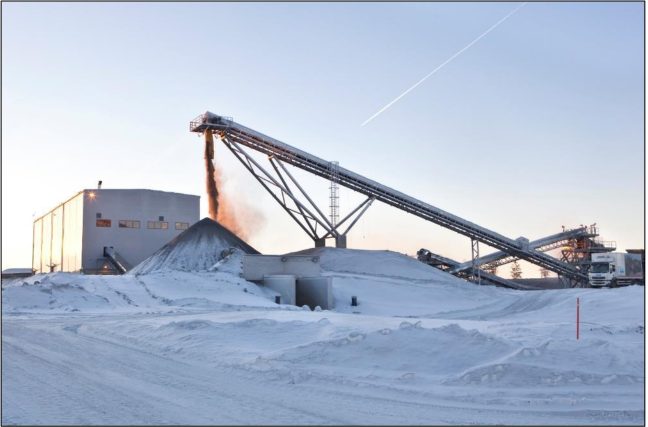
Kuva 15. Murskatun malmin siirto (Pampalon rikastamo, Endomines Oy)
