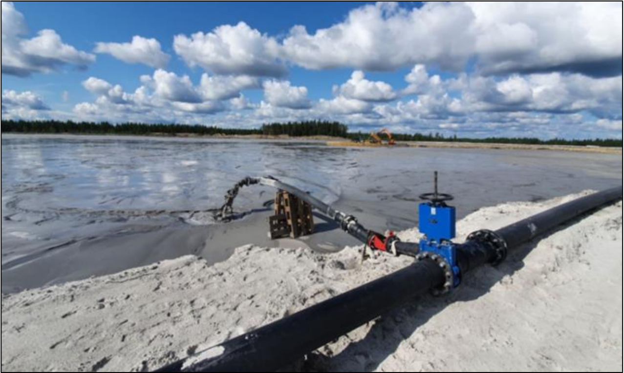
Kuva 23. Esimerkki rikastushiekan läjityksestä spigotoinnilla (kuva: Envineer Oy)
